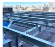
某ビル屋上発電機架台
